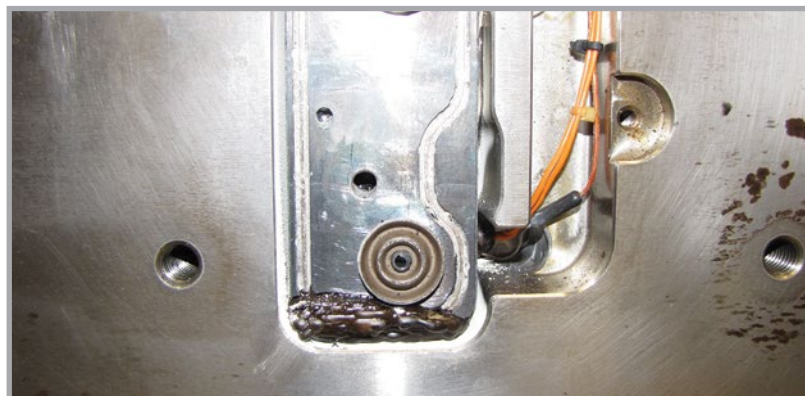
Erkennung auftretender Lecks mit Alarmfunktion
